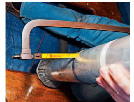
**9** ... Führung für die Säge verwendet werden. So lässt sich ein sehr gleichmäßiger Schnitt erreichen
