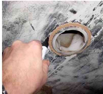
Eine Schablone hilft beim Anzeichnen der Ruderlagerkontur.
