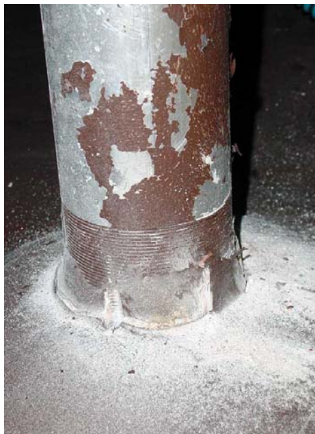
Das ausgeschnittene Rohr von innen betrachtet.
